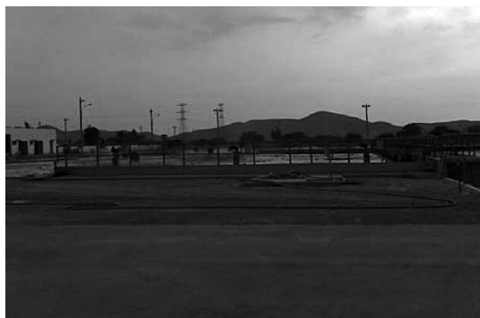
Vista del interior de la planta de tratamiento de aguas residuales Puente Piedra – lodos activados.
